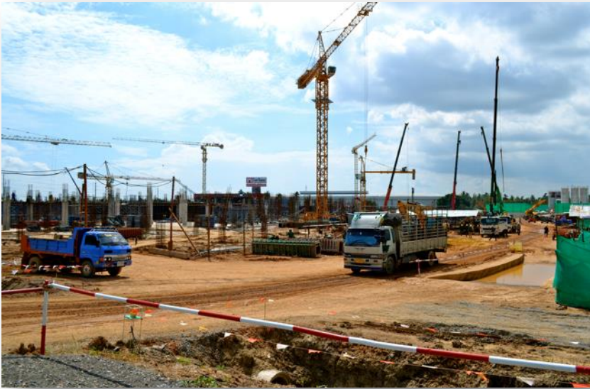
CentralPlaza Construction Site (Overview)
