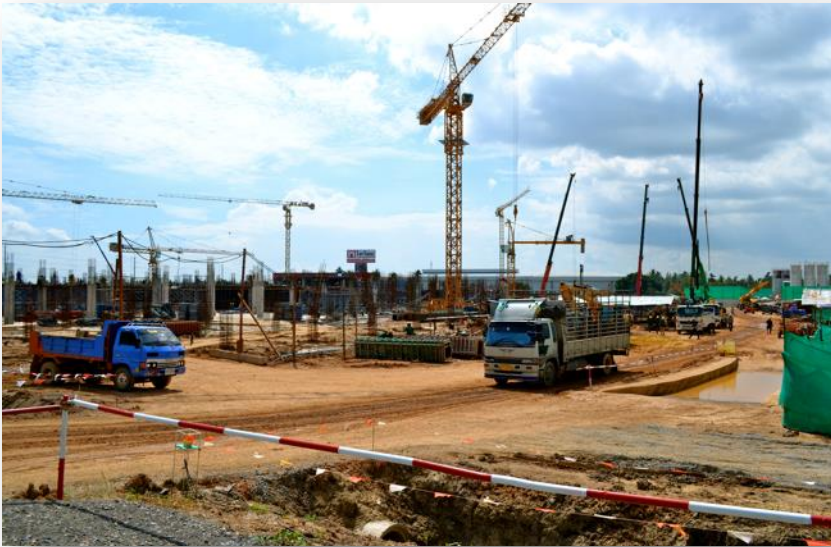
CentralPlaza Construction Site (Overview)
